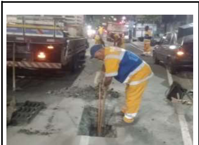
RUA JARDIM BOTÂNICO RENIVELAMENTO DE CAIXA RALO
