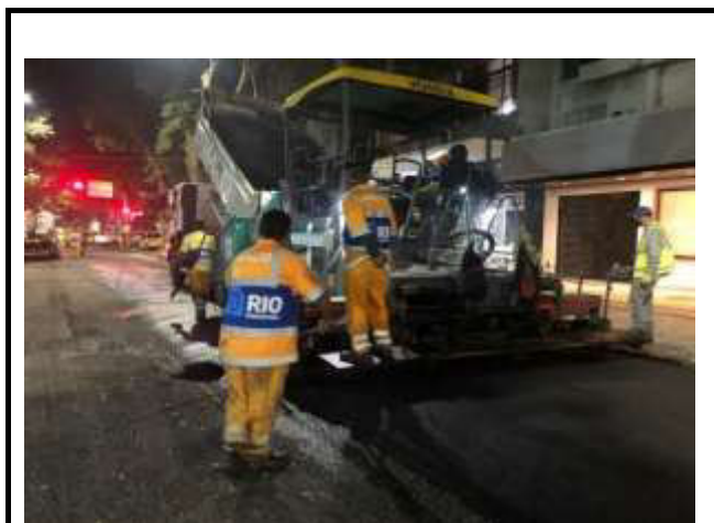
RUA SANTA CLARA ESPALHAMENTO DE CBUQ
