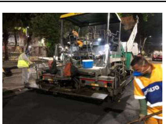
RUA SIQUEIRA CAMPOS ESPALHAMENTO DE CBUQ
