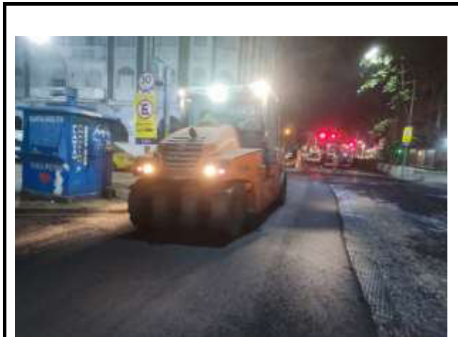
RUA CONSTANTE RAMOS COMPACTAÇÃO MECÂNICA
