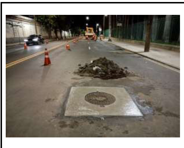
RUA JARDIM BOTÂNICO RENIVELAMENTO DE TAMPÃO
