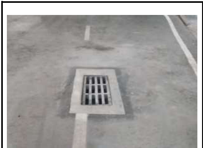
RUA JARDIM BOTÂNICO RENIVELAMENTO DE CAIXA RALO
