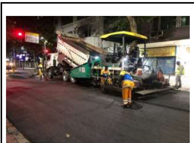
RUA SANTA CLARA ESPALHAMENTO DE CBUQ
