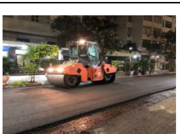
RUA SIQUEIRA CAMPOS COMPACTAÇÃO MECÂNICA
