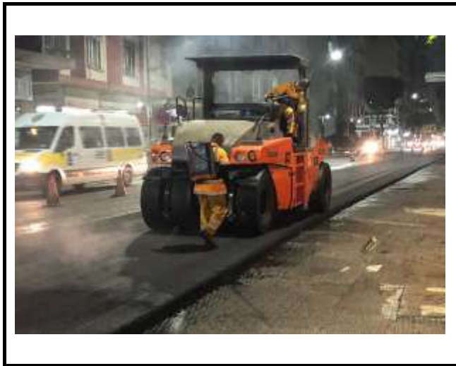
RUA BARATA RIBEIRO COMPACTAÇÃO MECÂNICA
