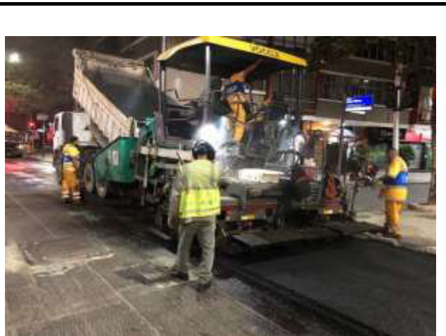
RUA BARATA RIBEIRO ESPALHAMENTO DE CBUQ
