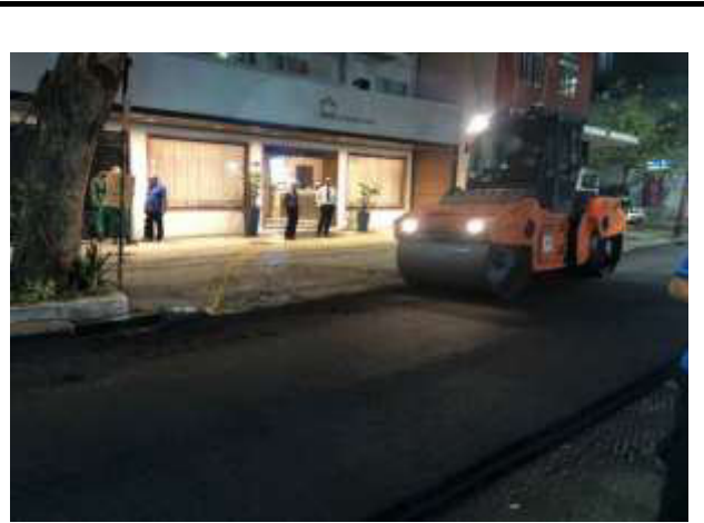
RUA SANTA CLARA COMPACTAÇÃO MECÂNICA
