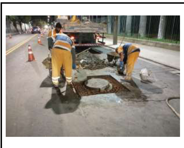
RUA JARDIM BOTÂNICO RENIVELAMENTO DE TAMPÃO
