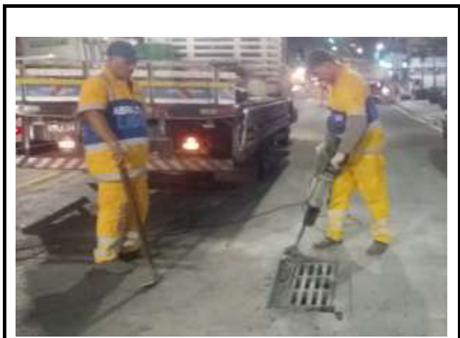
RUA JARDIM BOTÂNICO RENIVELAMENTO DE CAIXA RALO
