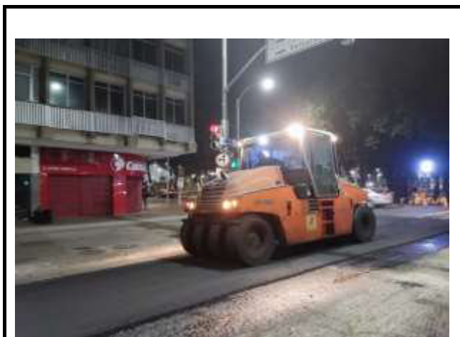
RUA SIQUEIRA CAMPOS COMPACTAÇÃO MECÂNICA
