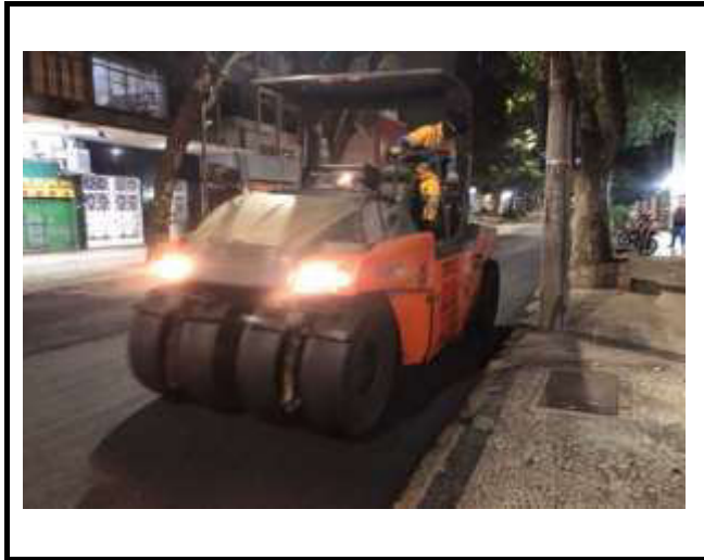
RUA SANTA CLARA COMPACTAÇÃO MECÂNICA
