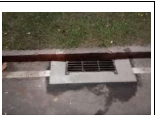
VIAS DO ATERRO DO FLAMENGO RENIVELAMENTO DE CAIXA RALO
