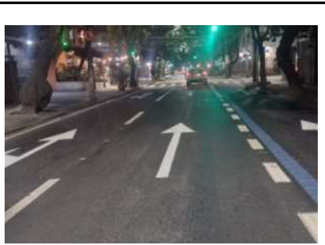
AV. ATAULFO DE PAIVA SINALIZAÇÃO HORIZONTAL
