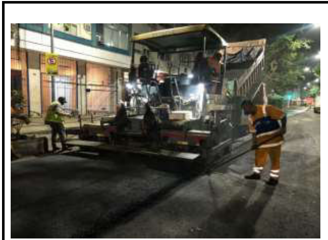
RUA CONSTANTE RAMOS ESPALHAMENTO DE CBUQ
