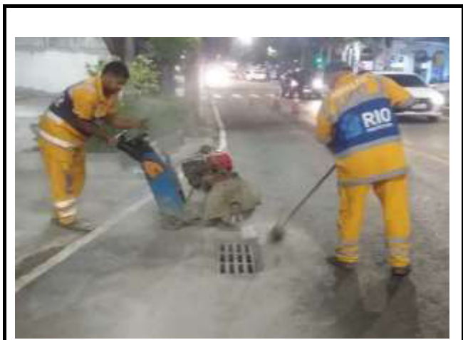
RUA JARDIM BOTÂNICO RENIVELAMENTO DE CAIXA RALO
