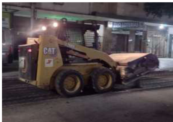
RUA SANTA CLARA LIMPEZA COM MINI CARREGADEIRA
