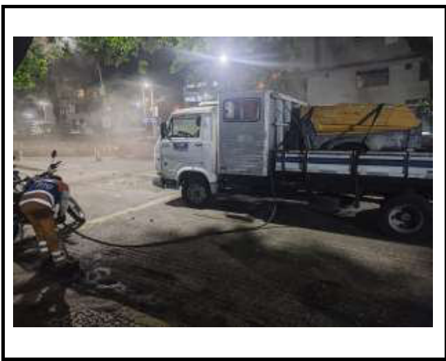
RUA FIGUEIREDO DE MAGALHÃES LIMPEZA COM COMPRESSOR DE AR
