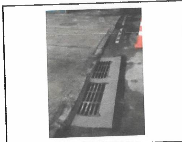
RUA VISCONDE DE SILVA LEVANTAMENTO DE CAIXA RALO
