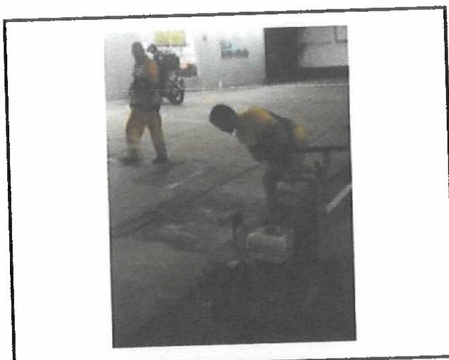
RUA VISCONDE DE SILVA LEVANTAMENTO DE CAIXA RALO
