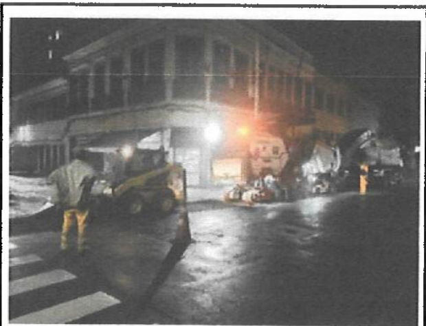
RUA VISCONDE DE RIO BRANCO LIMPEZA COM MINI-CARREGADEIRA
