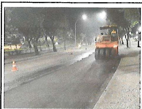
RUA ESTÁCIO DE SA COMPACTAÇÃO MECÂNICA
