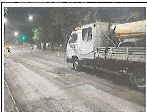
RUA ESTÁCIO DE SÁ LIMPEZA COM COMPRESSOR DE AR
