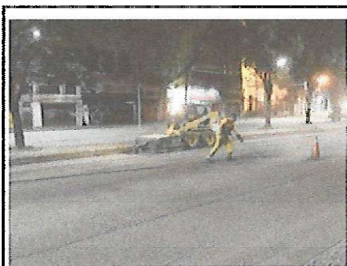
RUA ESTÁCIO DE SÁ LIMPEZA COM MINI-CARREGADEIRA
