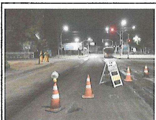
RUA ESTÁCIO DE SÁ SINALIZAÇÃO DE OBRA
