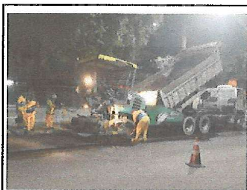
RUA ESTÁCIO DE SA ESPALHAMENTO DE CBUQ
