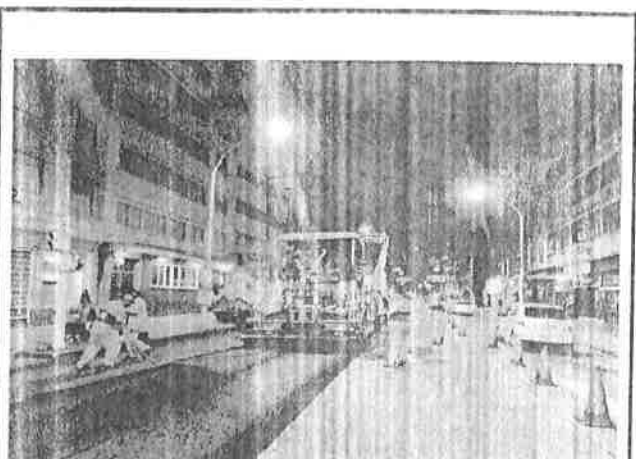
AV. NOSSA SENHORA DE COPACABANA ESPALHAMENTO DE CBUQ - 2ª CAMADA / CAMADA FINAL
