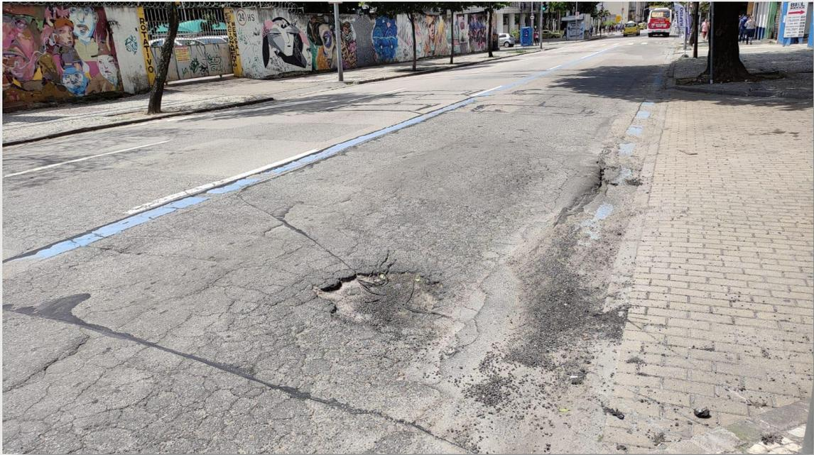
3. Foram observados também durante visita técnica ao local, que os dispositivos de drenagem superficial, encontram-se entupidos, impossibilitando o escoamento de água, acumulando sobre o pavimento, dificultando a execução dos serviços no logradouro, além de contribuir para a deterioração precoce do pavimento.
